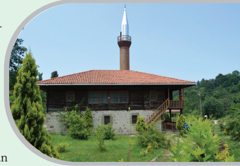
Hemşin Köyü Camii
