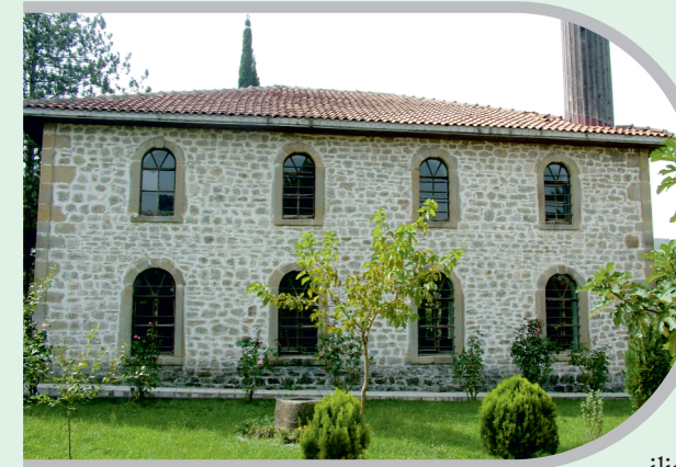
Uğurlu Köyü Yeni Meze Camii
